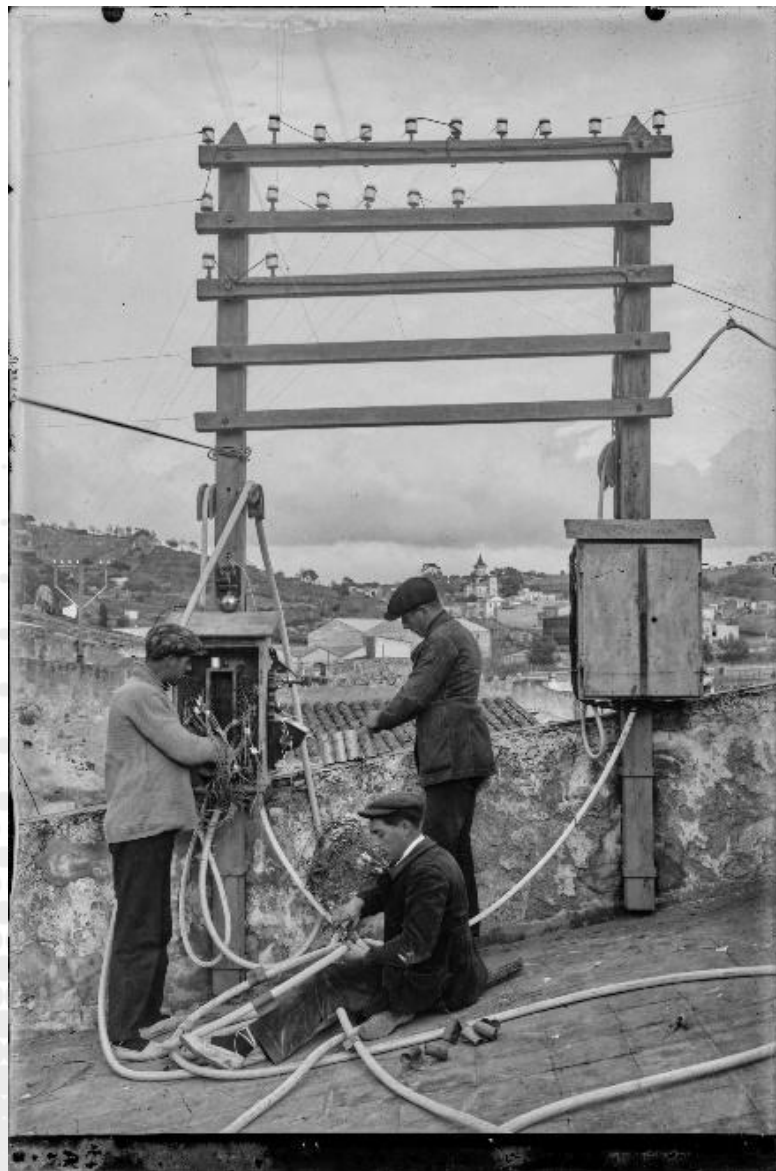
Grup d'operaris arreglant el cablejat, segurament de telèfon, sobre una teulada al voltants del molí de les Eres (1920-1925).
